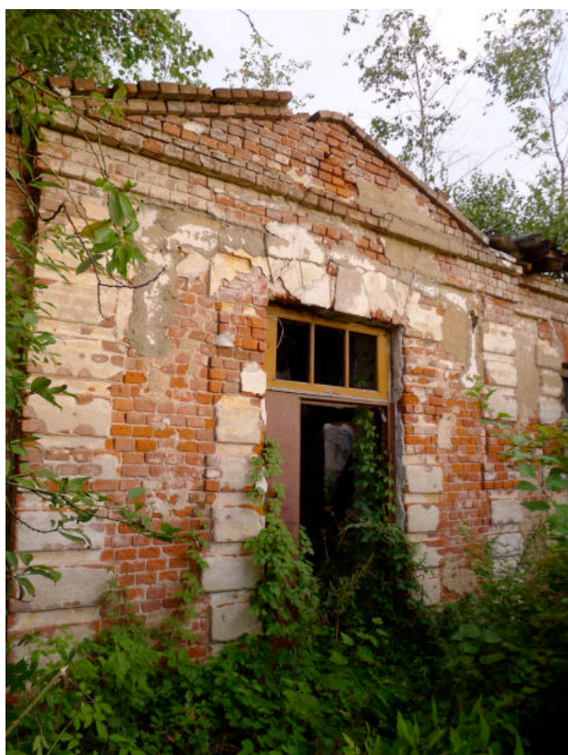
Фото 2. Средняя часть главного фасада.
