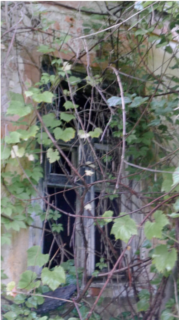
Фото 10. Окно на южном фасаде.
