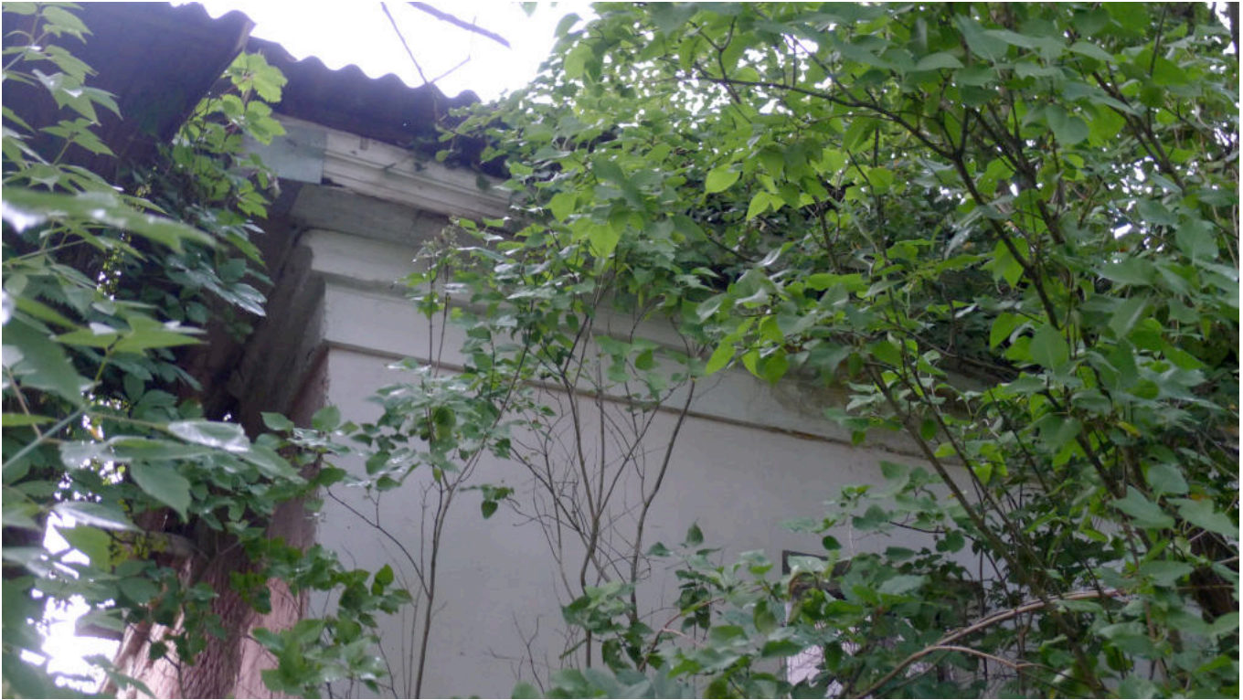
Фото 9. Юго-западный угол здания.
