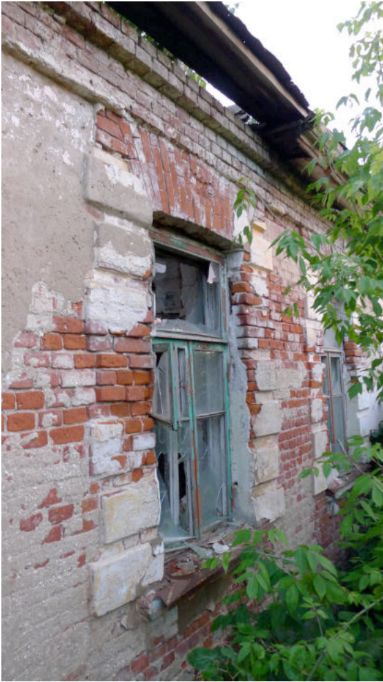
Фото 5. Окно на правом фланге главного фасада.
