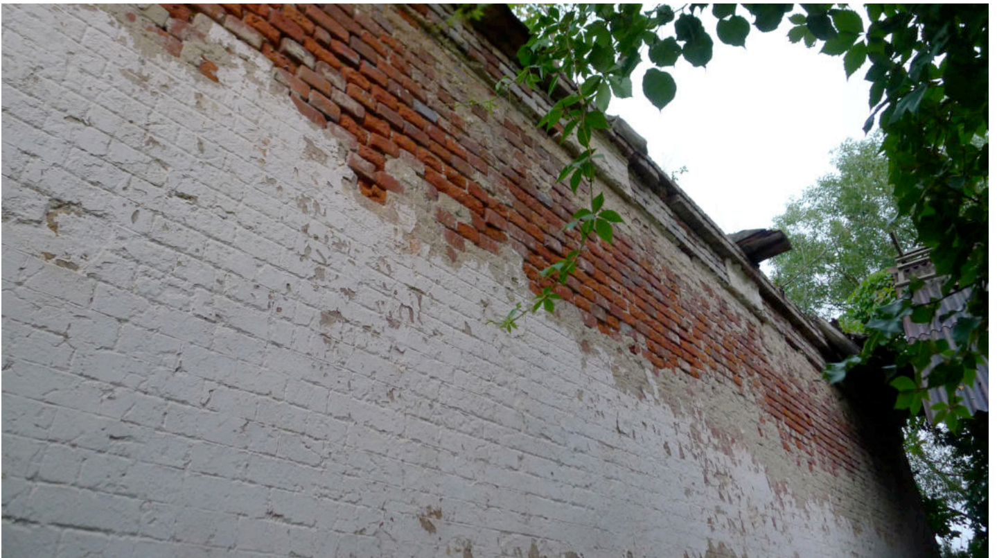
Фото 6. Западная стена здания.
