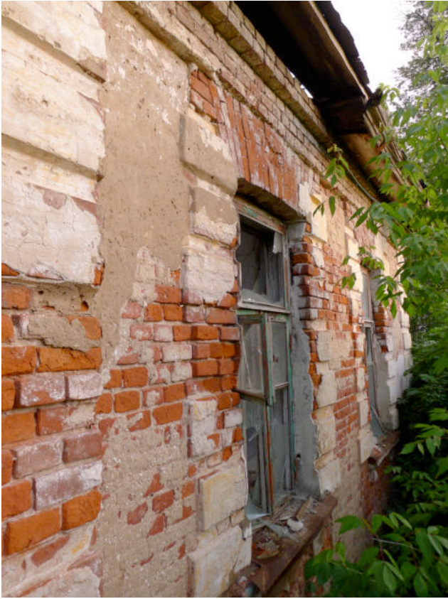
Фото 3. Правая часть северной стены.
