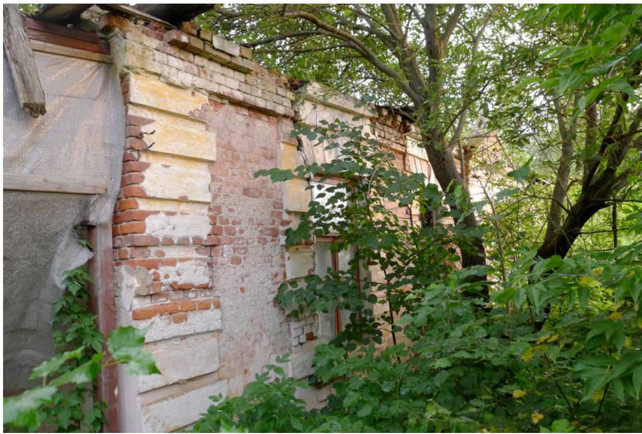
Фото 1. Северная стена здания – главный фасад, обращенный к Варшавскому шоссе.
