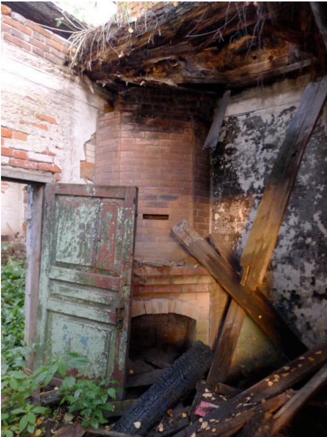
Фото 12. Камин в восточной части здания.
